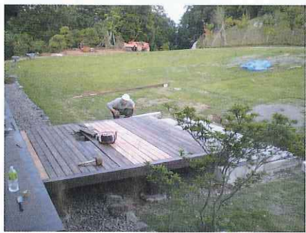
■ 床板を貼って最後の調整をする方丈
