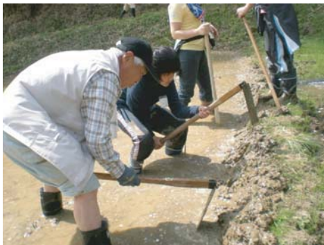
■ 田に張った水が漏れないように修復
