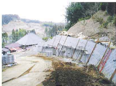
大きく回り込み、かつ急勾配であったため、最も施工が難しかった箇所。
