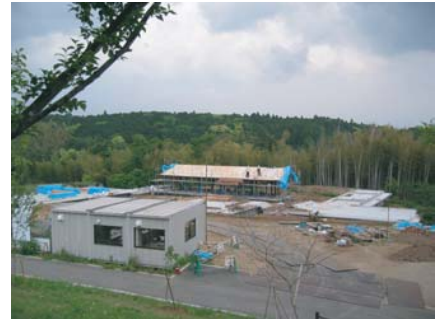
①観音堂の野地板貼り 07/05/15
