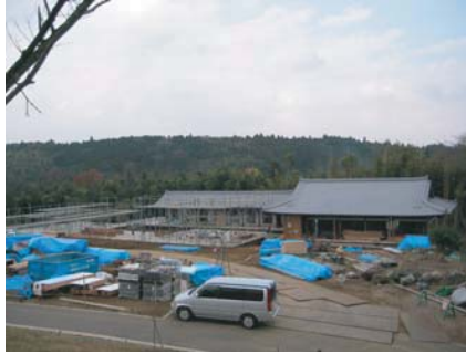
⑤方丈瓦葺きと仏殿足場 07/12/08
