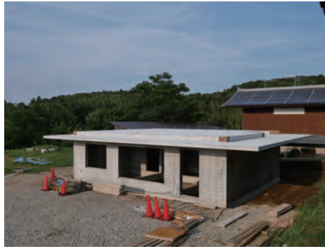
型枠を外した1F部分
