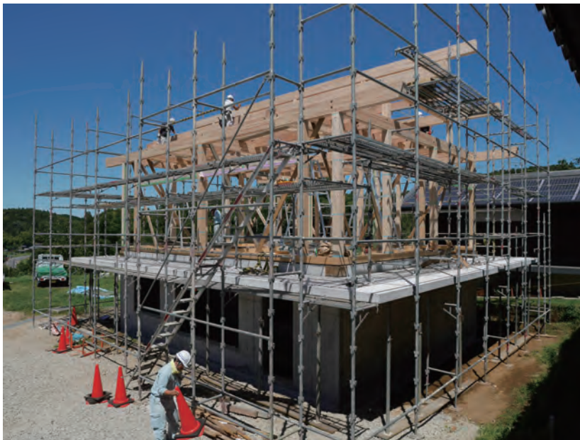
上棟が完了した新書院
