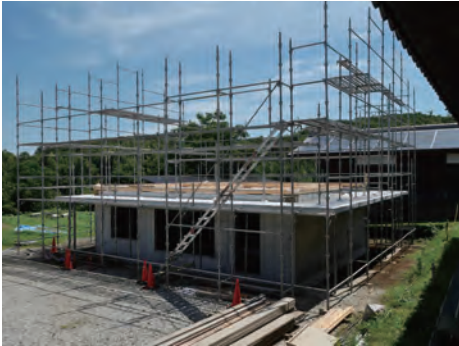
足場を組んで上棟に備えます
