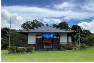
精霊棚設置後の薬師堂正面
