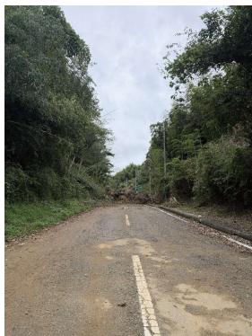
金堀通り 土砂崩れ通行止め
